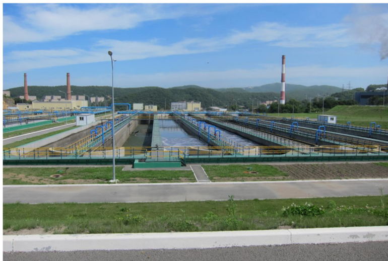
Рисунок 8 – Городские очистные сооружения сточных вод в г. Владивостоке
