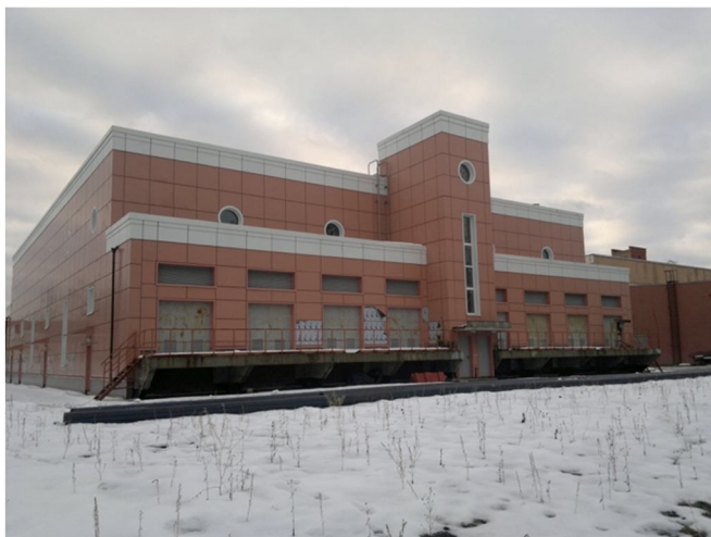
Рисунок 3 – Станция озонирования блока №1 Рублевской станции водоподготовки (в процессе строительства)
