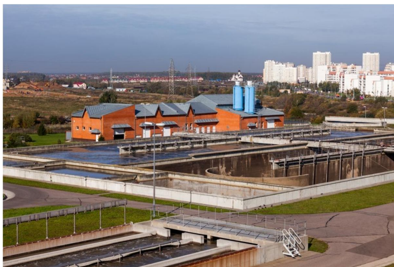
Рисунок 6 – Очистные сооружения «Южное Бутово», производительность 80 тыс. м 3 /сутки
