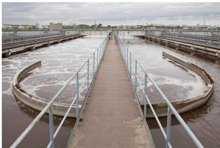
Рисунок 9 – Аэротенки Люберецких очистных сооружений в Москве
