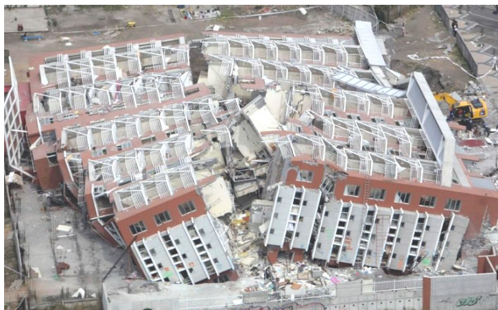
Рисунок 1 – Потеря устойчивости, разрушение и падение здания при землетрясении в Японии 11 марта 2011 г.
