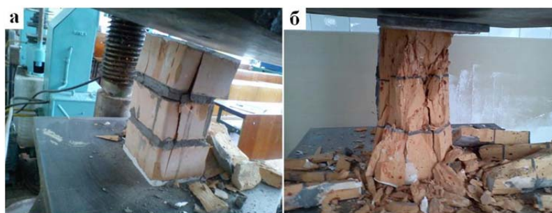
Рисунок 1 – Образцы кладки после испытания: а – традиционной; б – высококачественной
