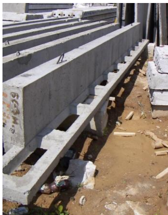
Рисунок 2 – Общий вид перфорированного обвязочного ригеля
