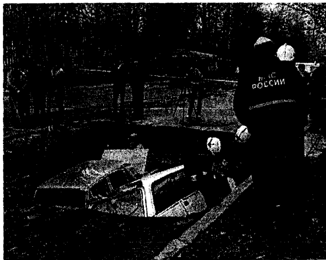
Рис. 2. Провал на ул. Краснова в г. Перми в результате размыва грунта по причине протечек из коллектора водовода трения – \phi = 19...21^\circ ; модуль деформации – E = 8...10 МПа.
