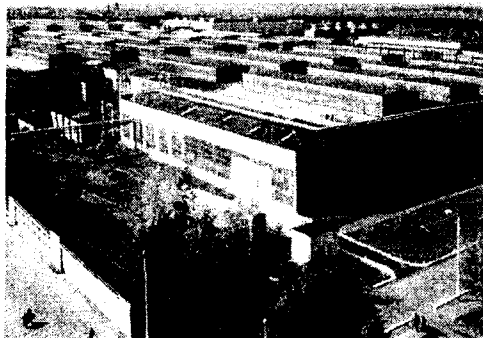
Рис. 2. Голые стены верхней части здания производственного комплекса преумножают число гомогенных полей в г. Орле. В здании также мало кривых линий и много прямых
