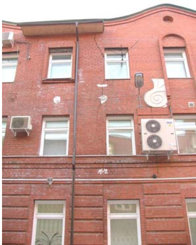
Рис. 1. Развитие вертикальных и наклонных трещин вследствие неравномерной осадки
