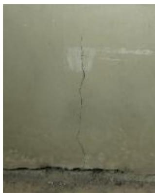
*Рисунок 15 – Фотография стеновой панели второго этажа с вертикальной трещиной в опорной зоне*
