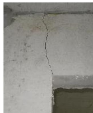
*Рисунок 16 – Фотография стеновой панели второго этажа с вертикальной трещиной в надпроемной перемычке*
