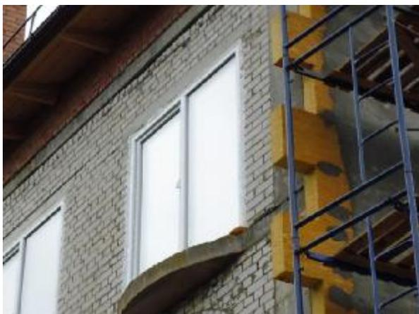
**Рисунок 1 – Фрагмент здания, утепляемого плитами из минеральной ваты**
