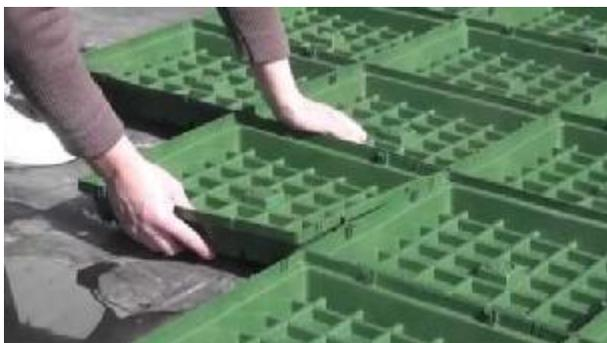
**Рисунок 1 – Устройство модульных зеленых кровель**
