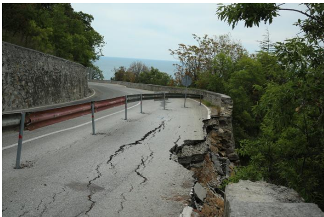
Рисунок 3 – Сквозной вывал в подпорной стене Алушкинского шоссе
