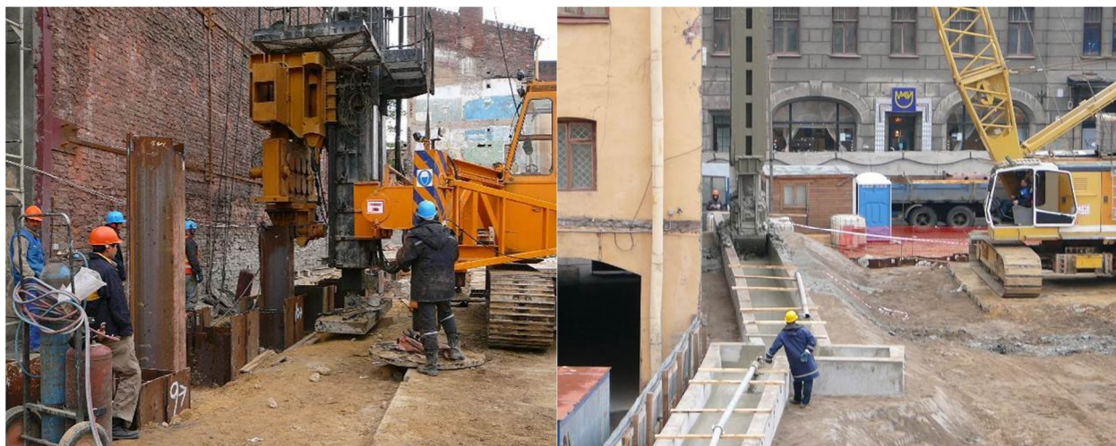
Рисунок 1 – Погружения шпунта и устройство «стены в грунте» возле существующих зданий на объекте «Стокманн Невский Центр» в г. С.-Петербург
