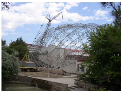
Рисунок 11 – Арочный каркас под тентовое покрытие
