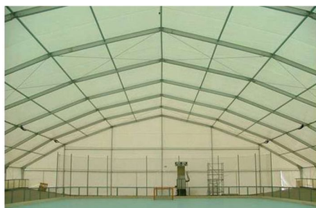
Рисунок 19 – Спортивное сооружение, компания «VIP Sport Construction», Азербайджан, vip sport.az.
