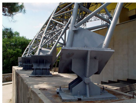
Рисунок 12 – Шарнирно-неподвижные опоры наклонных арок
