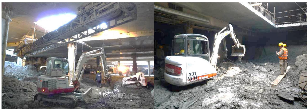
Рисунок 2 – Разработка грунта по методу «Top-Down» при строительстве многофункционального центра «Стокманн Невский Центр» в г. С.-Петербург
