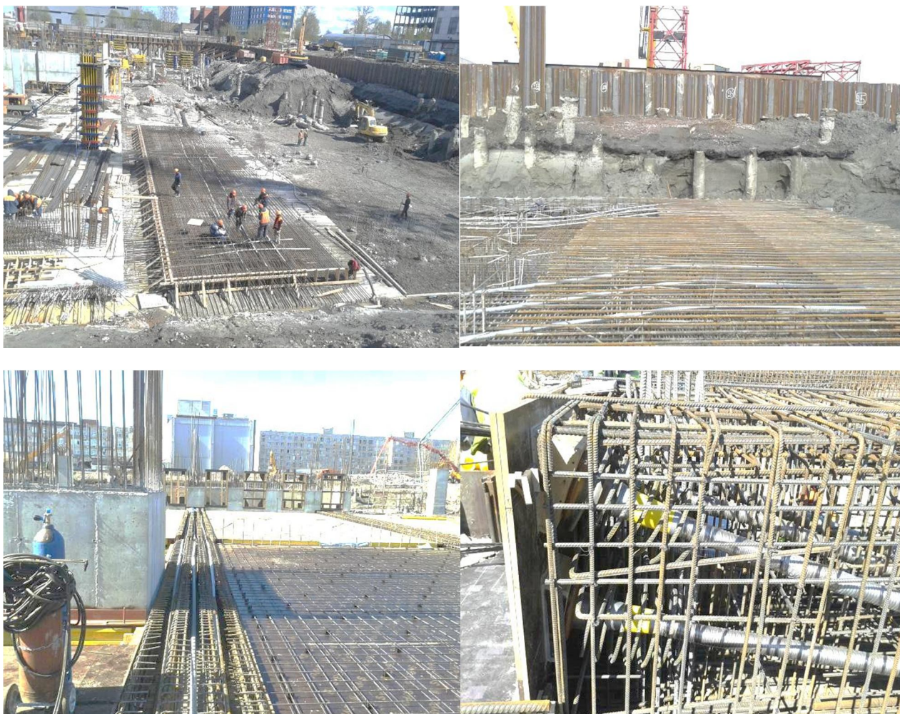
Рисунок 3 – Укладка гофрированных труб для канатов постнапряжения на объекте «Охта Молл» в г. С.-Петербург
