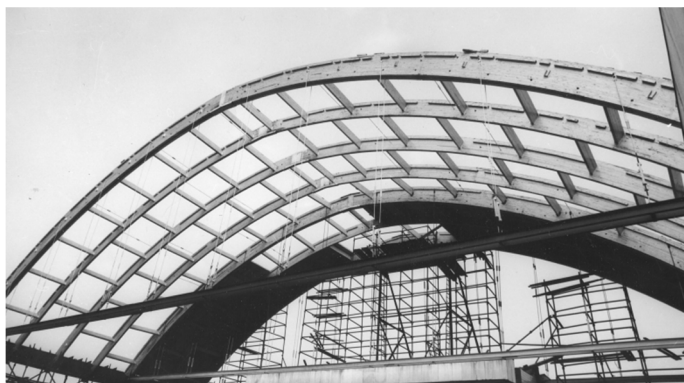
Рисунок 1 – Монтаж короткой цилиндрической оболочки пролетом 42 м
