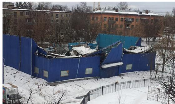
*Рисунок 16 – Обрушение покрытия типового физкультурно-оздоровительного комплекса, г. Королев, Московская обл., зима 2013 г., фото Д.А. Лысова*
