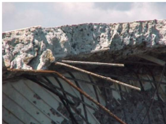
*Рисунок 13 – Фрагмент купола после обрушения [5]*
