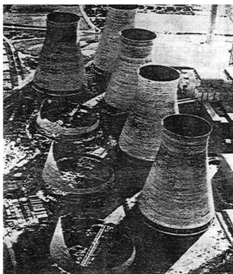
*Рисунок 3 – Общий вид градирен в г. Феррибридж после штормового ветра [3]*
