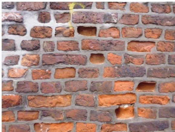
*Рисунок 3 – Кирпичная кладка, начало XVIII в. Разрушенный кирпич при сохранившемся связующем*
