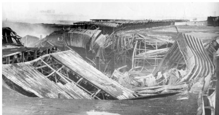
Рисунок 19 – Прогрессирующее обрушение конструкций производственного здания из металлических конструкций в результате пожара
