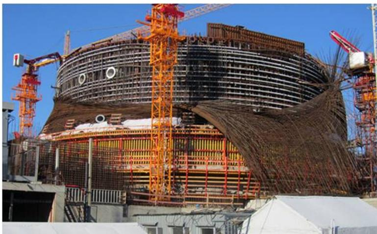
*Рисунок 9 – Обрушение пространственного металлического каркаса при возведении первого энергоблока ЛАЭС-2*
