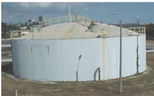
Рисунок 11 – Железобетонный резервуар для жидкости до разрушения
