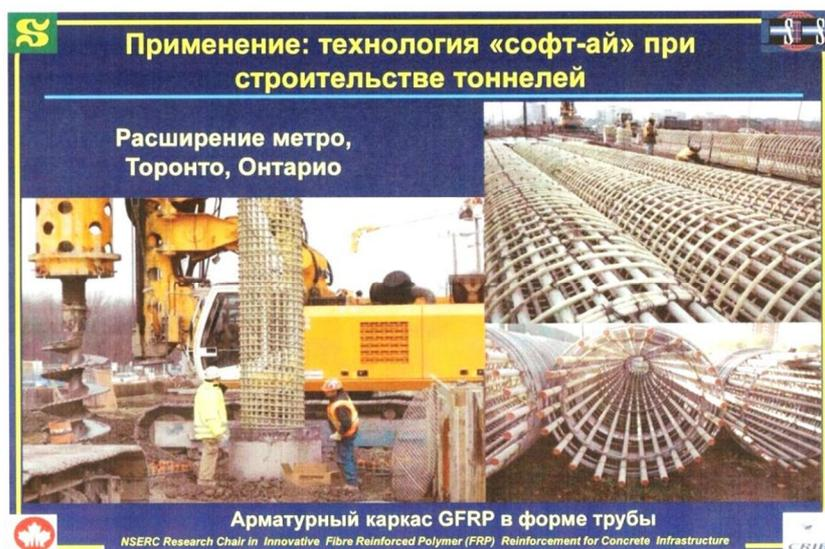
Рисунок 3 – Пример технологии «софт-ай» при строительстве тоннелей в г. Торонто, Канада
