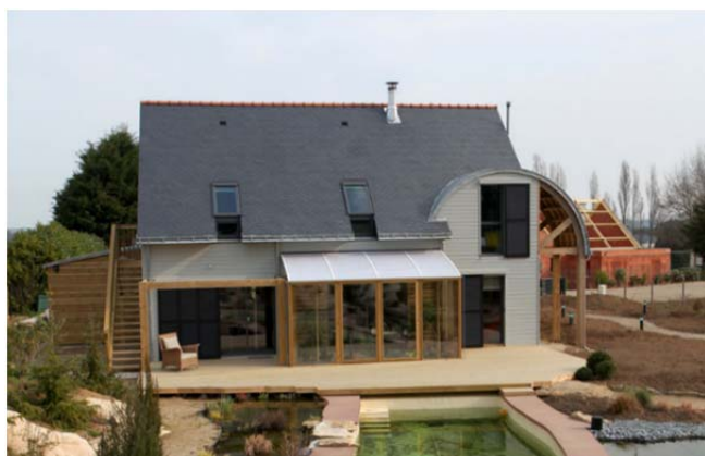
Рисунок 1 – Оранжерея для нагрева воздуха в энергоэффективном доме, Франция
