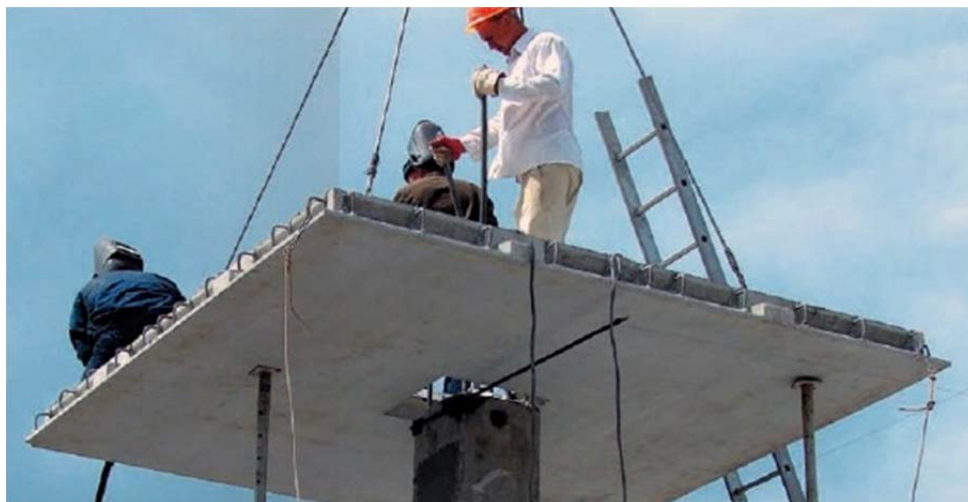
Рисунок 4 – Процесс центровки отверстия надколонной плиты относительно колонны в системах КУБ-2,5 и КБК, выполняемый с помощью лома
