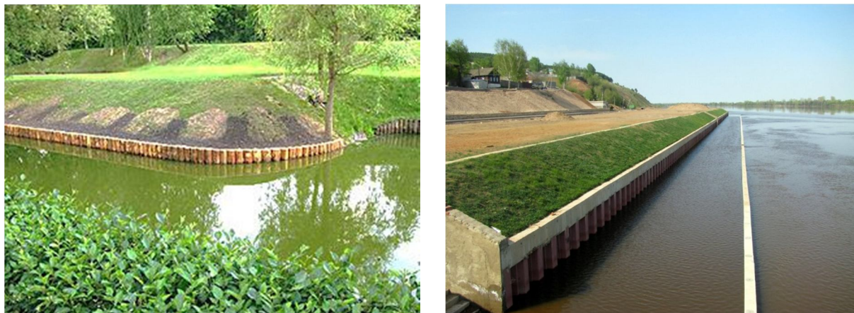
Рисунок 6 – Устройство берегоукрепительных сооружений
