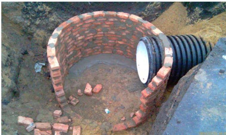
*Рисунок 2 – Переходной колодец строящегося коллектора*
