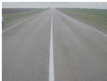
Рисунок 3 – Общий вид отремонтированного участка после нанесения дорожной разметки
