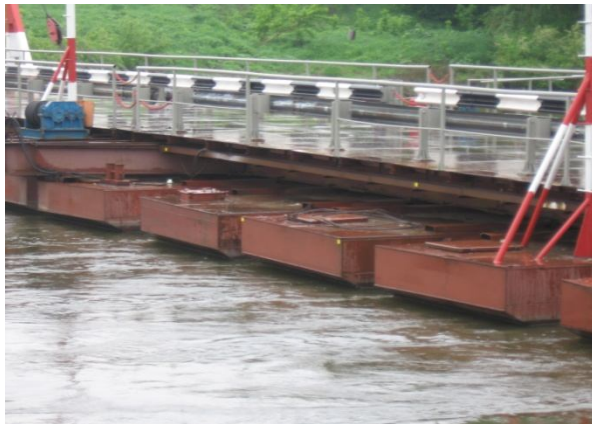
Рисунок 4 – Вид моста с установленными калиброванными эталонными метками
