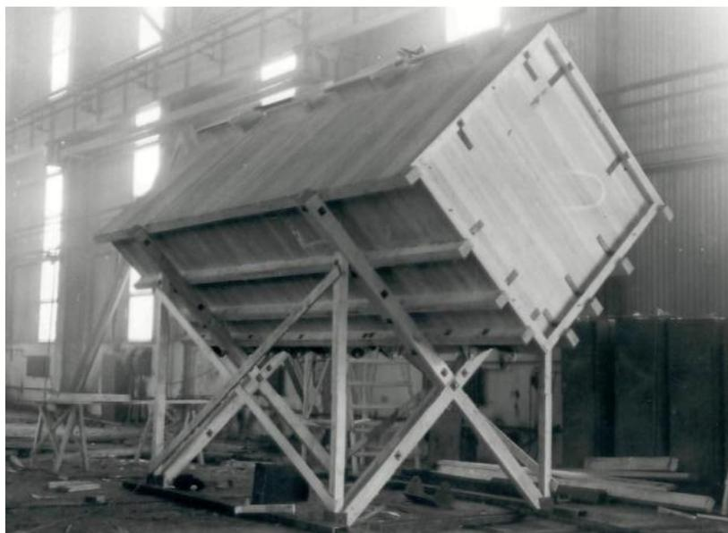
*Рисунок 2 – Общий вид бункера для зерна с применением древесины размерами  $2 \times 2 \times 6,2$  м (объем  $24$  м<sup>3</sup>)*
