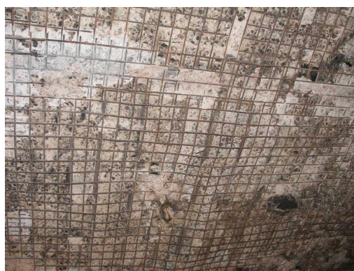
Рисунок 1 – Плита перекрытия с противооткольной сеткой после пожара
