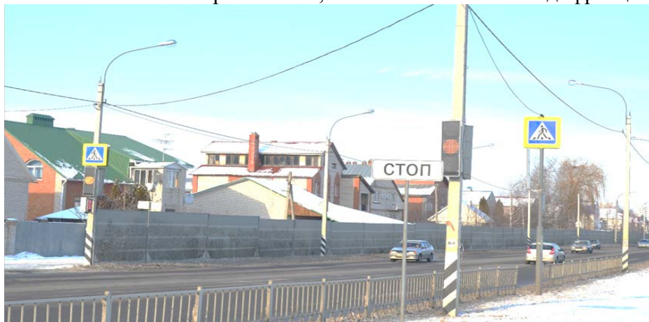
Рисунок 1 - Шумозащитные сооружения по улице Мостовой
