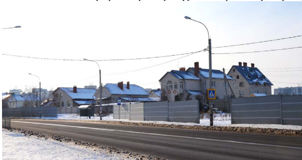
Рисунок 3 - Места нарушения сплошности экрана
