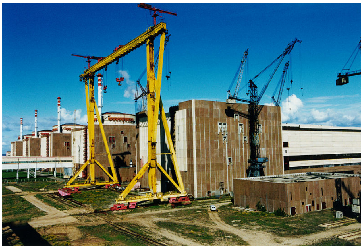
Рисунок 2 - Кран K2x190 монтирует купол энергоблока Балаковской АЭС
