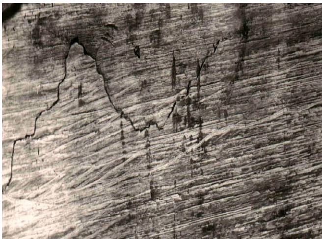
Рисунок 4 – Усталостные трещины на рабочей поверхности гребня бандажа
