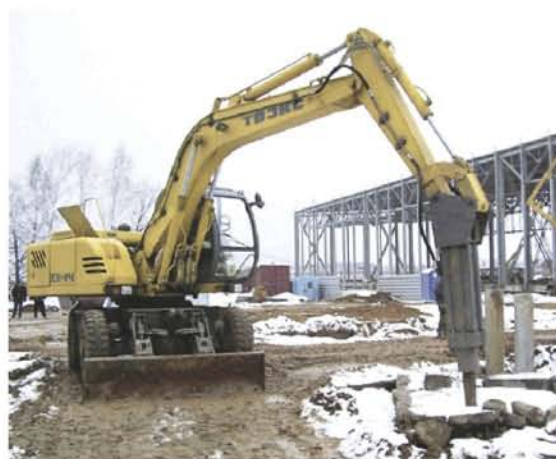
Рисунок 1 – Рыхлаение мерзлых грунтов при помощи гидромолота
