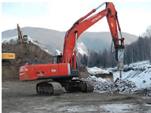
Рисунок 1 – Рыхлаение мерзлых грунтов при помощи гидромолота
